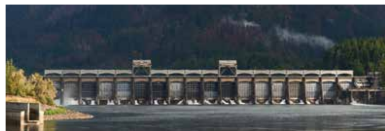
▲ Un barrage hydro-électrique sur la Columbia River.
